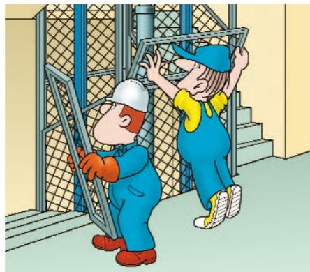
**Difese di vano:** negli impianti inseriti in vano scala, le protezioni che delimitano il vano corsa devono avere un'altezza minima dal piano di calpestio, di 2.5 m
